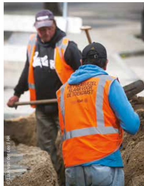
▲ Aanleg van FttH in de gemeente Rheden door Reggefiber, april 2014.
